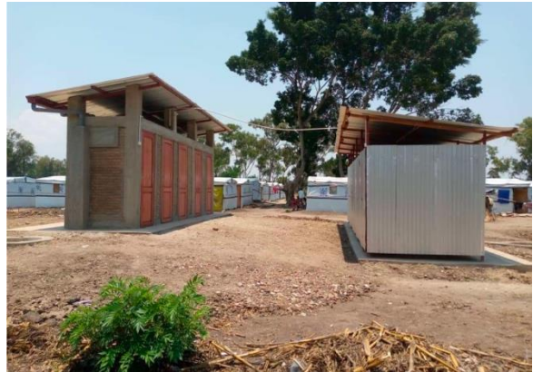
Wie hier in Burundi ist eine der ersten Maßnahmen in überschwemmten Dörfern oder Camps die Verbesserung der hygienischen und sanitären Bedingungen. Der Bau von Toiletten und Duschen führt zu besserer Gesundheit und gehört zu einem würdigen Leben dazu. Wichtig: Die Türen. Sie erlauben – was zuvor meist nicht der Fall ist – die notwendige Privatsphäre herzustellen.
